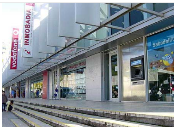
Façana de l'edifici singular a l'av. Via de la Plata
