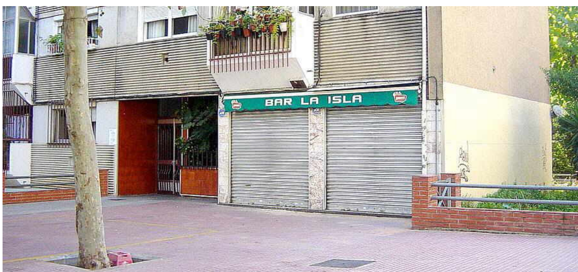
Local tancat al carrer Eivissa.
