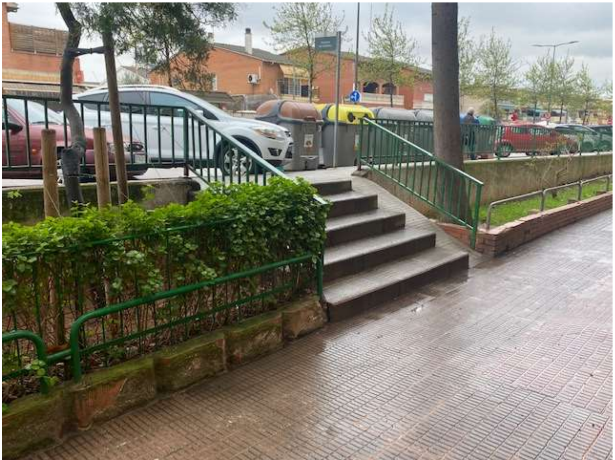
Millora de l'accessibilitat a l'Av. Cantàbric 25-31 / Oficina Tècnica Territori / Ajuntament de Badia del Vallès
