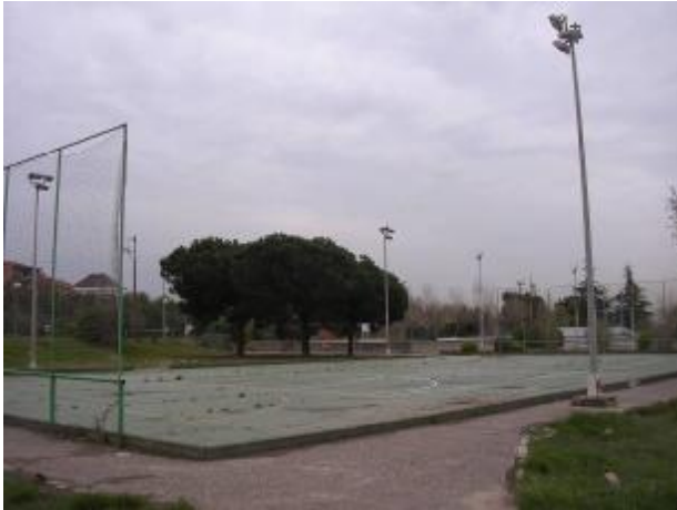
Imatge 2. Aspecte d'una de les dues pistes poliesportives abandonades situades entre les pistes de tennis, el camp de futbol de terra i l'aparcament.
