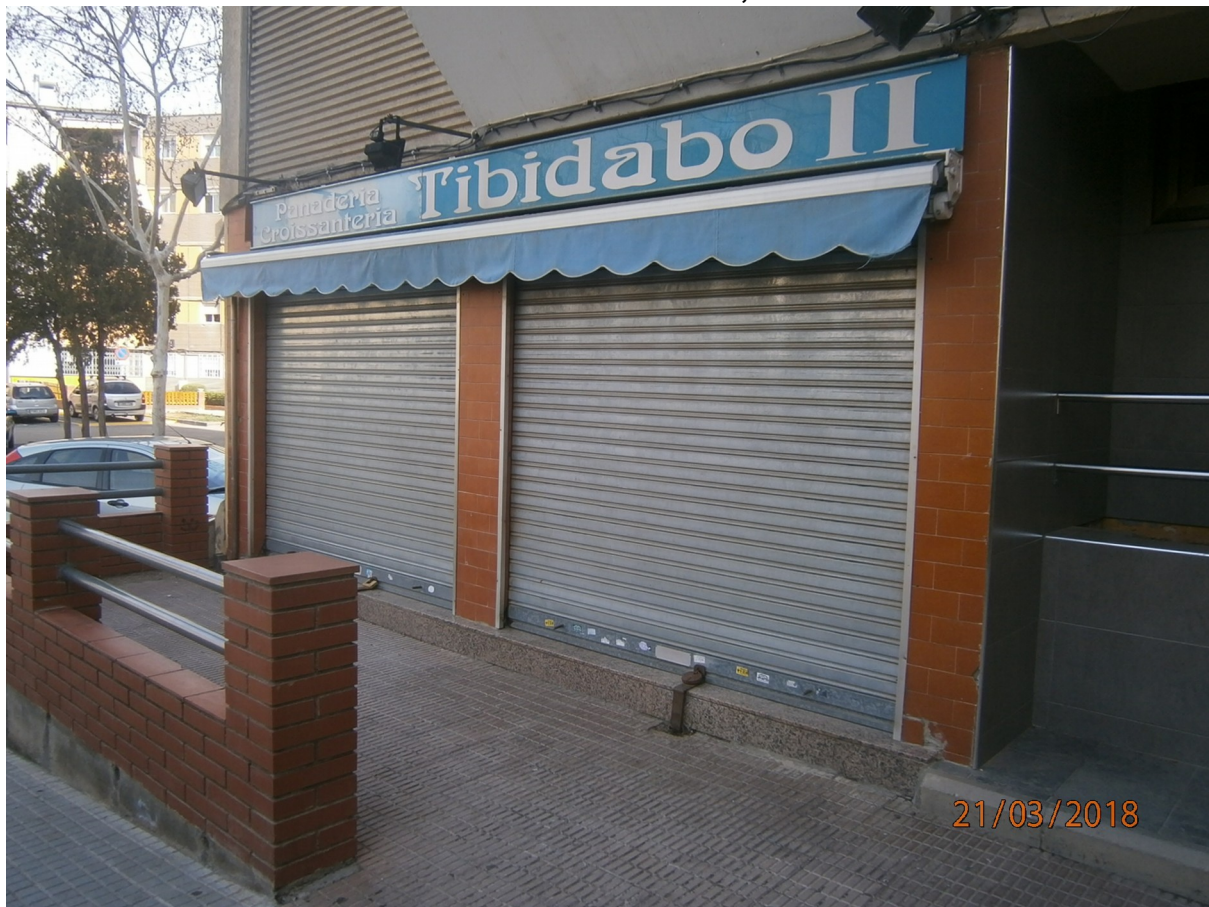
FOTOGRAFIES DE L'ESTAT ACTUAL DEL LOCAL 36, AL CARRER SANTANDER 10
