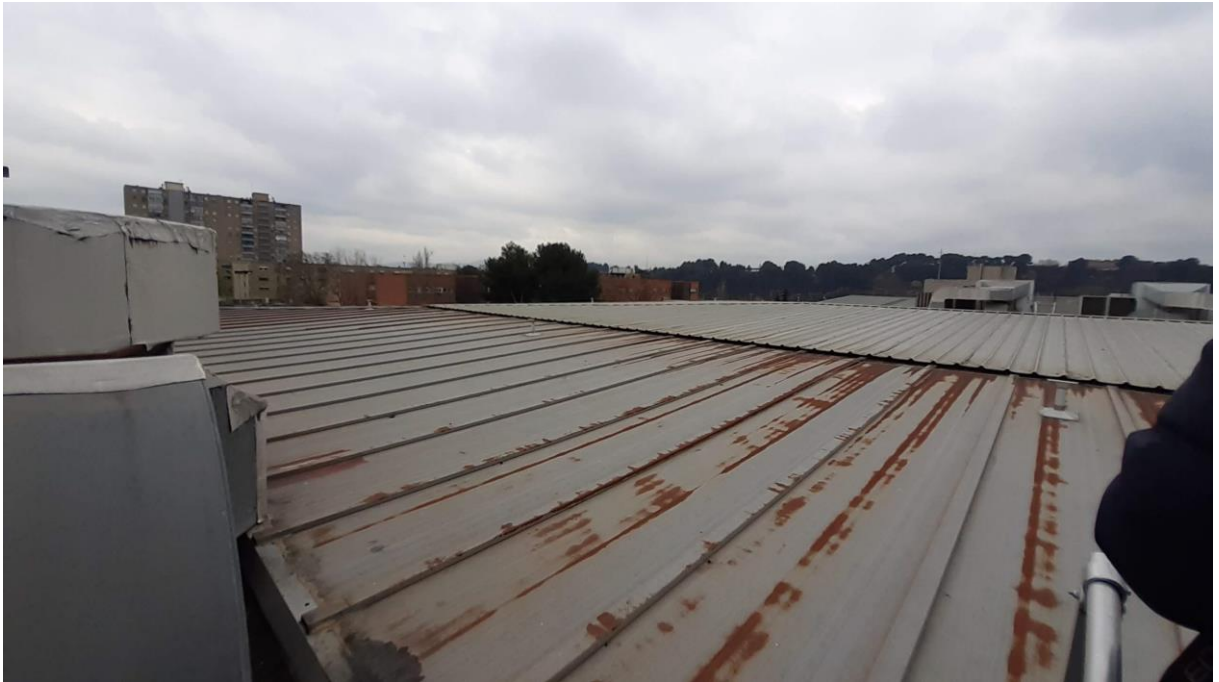
Vista de la cubierta
