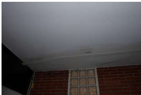
Reparació junta sostre. Revisió i repàs de la coberta inclinada de teula àrab.
